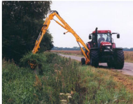
Abb. 11, Abb. 12: Entkrautung zugewachsener Entwässerungsgräben. Aufgrund der hohen Kosten werden die Gräben oft nur auf einer Seite und nur einmal im Jahr entkrautet. (eig. Aufn. nahe Dosse und Jäglitz, Sommer 2002)
